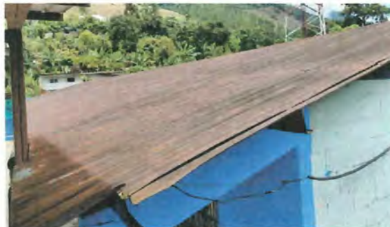
Foto 2: Sustitución de lámina por deterioro por paso del tiempo, imagen parcial de donde se localizan aulas, bodega y baños.
