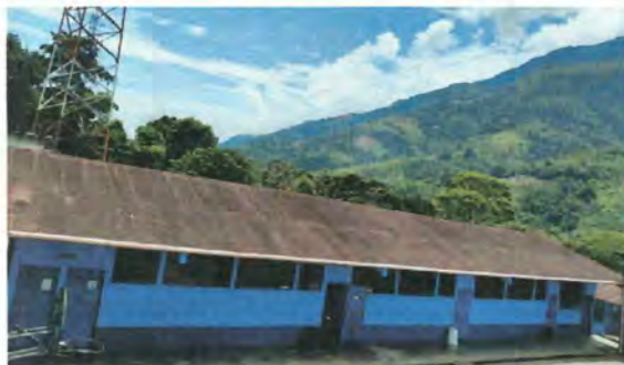
Foto 1: Sustitución de lámina por deterioro por paso del tiempo, imagen parcial de donde se localizan aulas, bodega y baños, modulo del lado Este.
