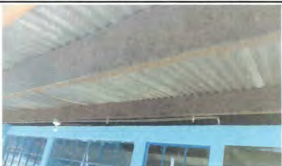
Foto 5: Mantenimiento de estructura metálica en el area de aulas, debido a que presentan corrosión en su mayor parte.
