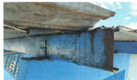
Foto 4: Mantenimiento de estructura metálica debido a que presenta corrosión en algunas partes.
